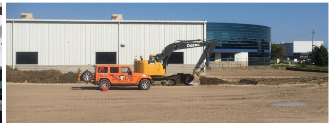
Comenzó la construcción de la ampliación de 50,000 pies cuadrados y se prevé que finalice en febrero de 2017.
