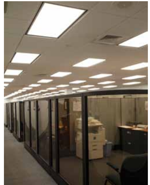
Reacondicionamiento de iluminación - La mayoría de las plantas de Leggett utilizan sistemas de iluminación de alta eficiencia que reducen el consumo energético casi un 50% y crean un ambiente de trabajo más iluminado y seguro. Se pueden encontrar ejemplos adicionales de ahorro de energía en www.leggettgreen.com .
